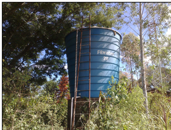
Foto – Reservatório Linha Santa na de Bela Vista
