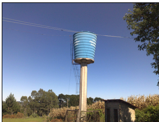
Foto – Reservatório Linha Planalto
