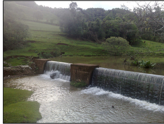
Foto – Barragem da Captação
